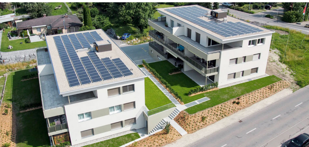
Impianti fotovoltaici sulla casa plurifamiliare di Ponyweid.
