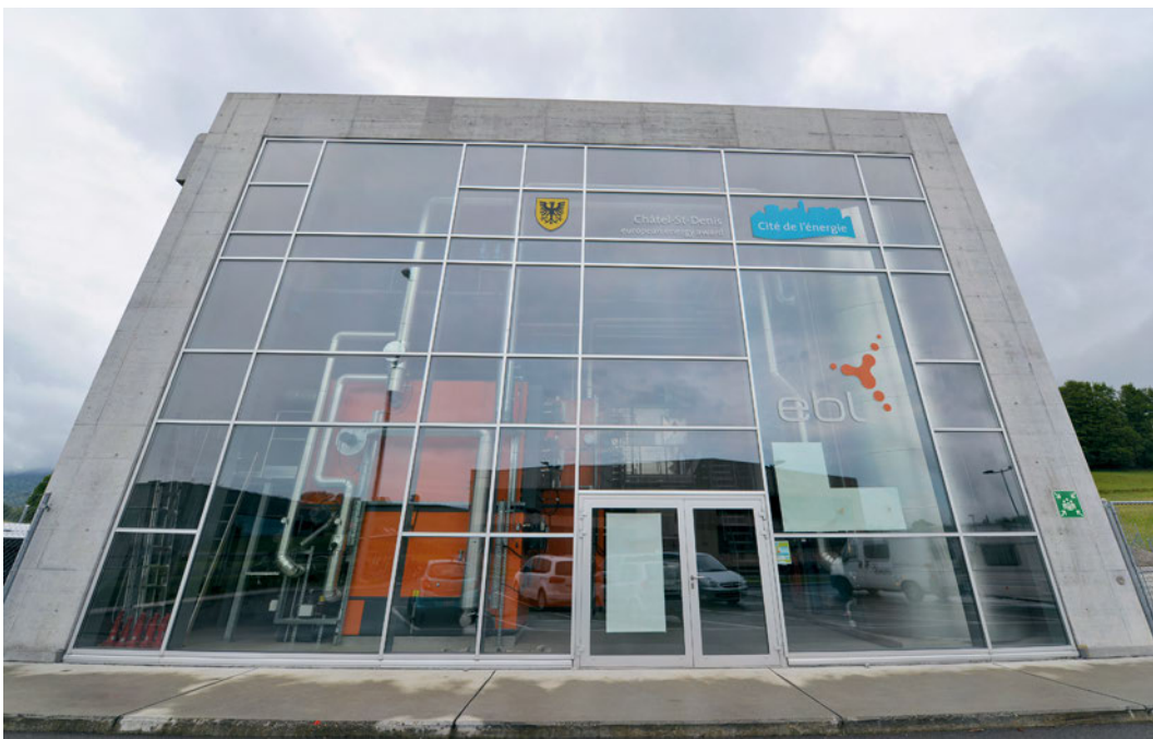
L'edificio in calcestruzzo e vetro permette di ammirare le tubature d'acciaio e la caldaia arancione.
