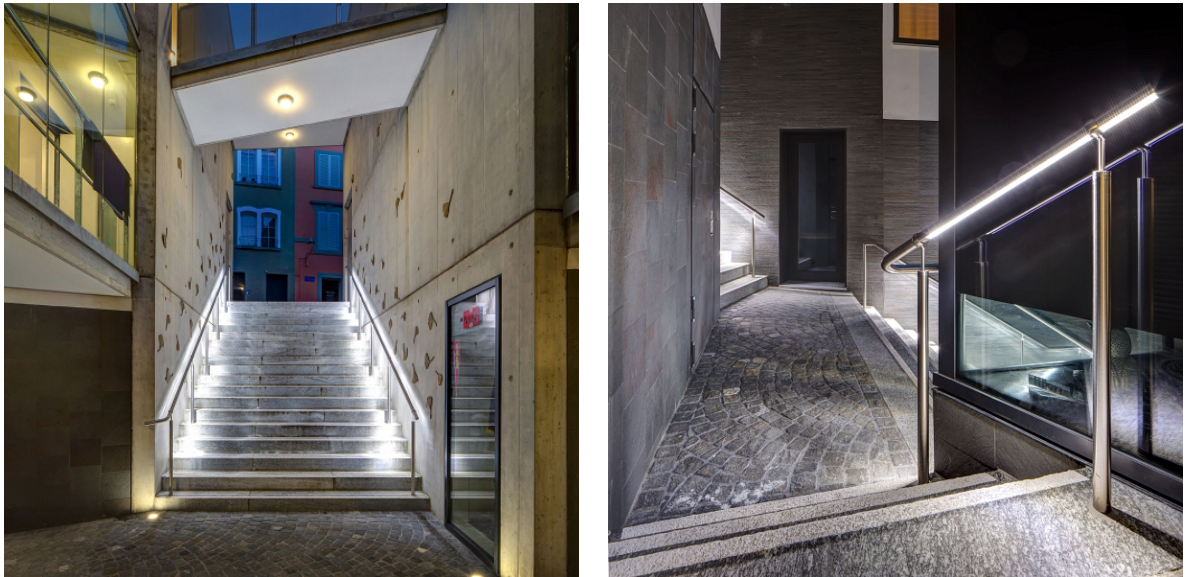
Abbildung 18: Im Quartier du Rôtillon von Lausanne werden die Treppen mit im Handlauf platzierten LED zusätzlich beleuchtet. Die einzelnen Absätze sind zudem noch mit weissen, rutschfesten Streifen versehen, die den Kontrast erhöhen (Quelle: Ville de Lausanne 15 ).
