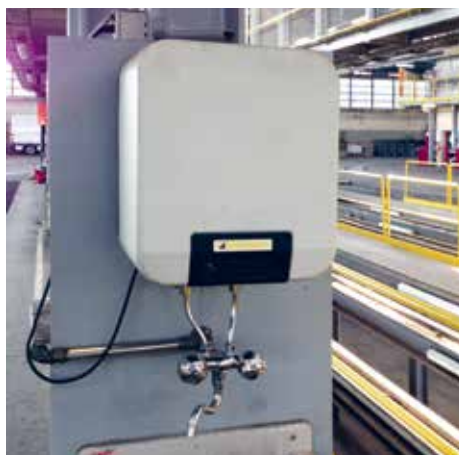
Illustration 3.14: Parfois la meilleure solution: un chauffe-eau décen- tralisé. Projet: Trans- ports publics VBZ, dépôt de trams, Zurich-Oerlikon.
