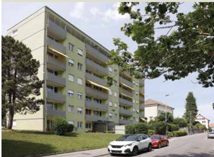
Il risanamento è stato realizzato in due fasi nell'arco di più anni.
